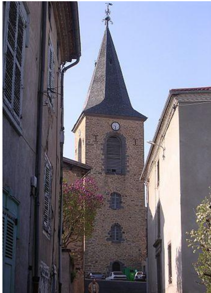
Clocher à flèche de charpente, Massiac ( Via Arverna ).
